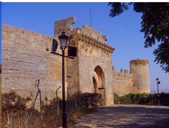
写真3 城砦・パラドール正面
